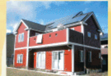
太陽光発電システム
