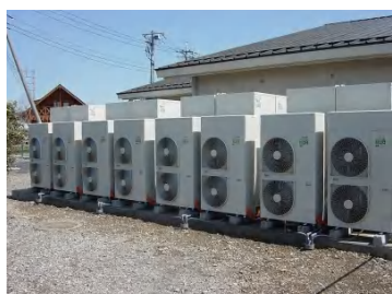
高効率ヒートポンプ給湯器
