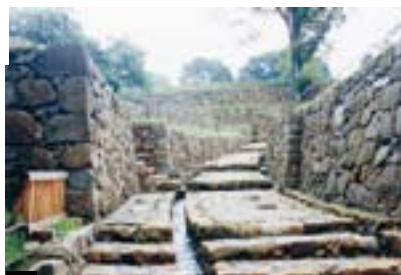
12 大手虎口:実城へ向かうための通路を厳重に守っていた一大防御拠点。高く積まれた石垣は、敵を威圧し、城の威厳を示します。
