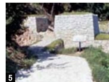
5 物見台下虎口:通路の正面に石積みがあり、その先を見せないような工夫がされています。
