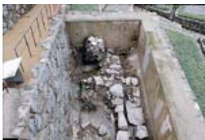
13 石垣改修の露出展示:5回も石垣の改修工事を行なっている跡が見られます。
