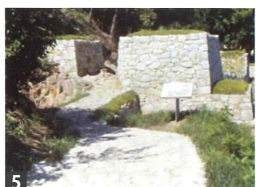
5 物見台下虎口：通路の正面に石積みがあり、その先を見せないような工夫がされています。
