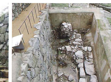
13 石垣改修の露出展示：5回も石垣の改修工事を行っている跡が見られます。
