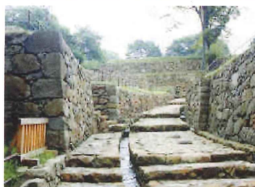
12 大手虎口：実城へ向かうための通路を厳重に守っていた一大防御拠点。高く積まれた石垣は、敵を威圧し、城の威厳を示します。
