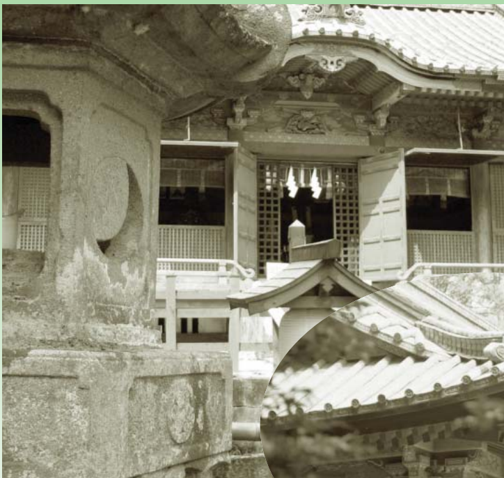
正面から見た拝殿
