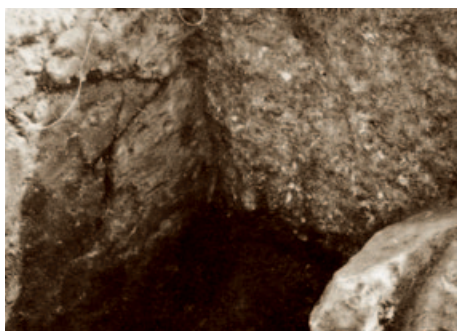
奥壁裏込め状況 (昭和45年)
