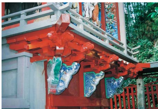
修復作業中の冠稲荷神社本殿
