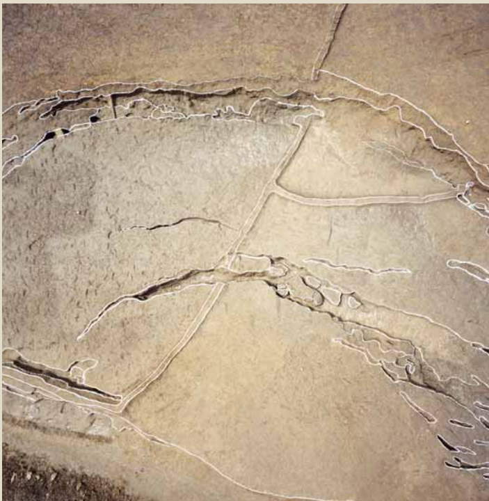
地震による陥没（東から）
