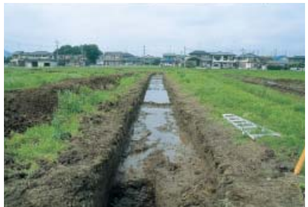
試掘トレンチ設定状況
