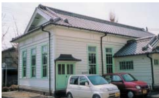
旧金山図書館修復状況
