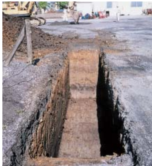
試掘トレンチ掘削状況
