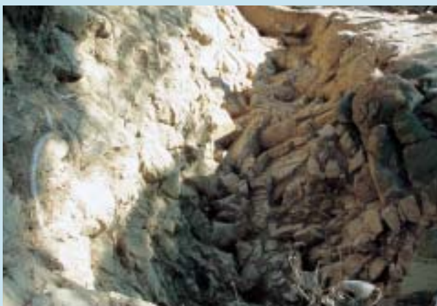
威圧感溢れる北堀切の堀底
