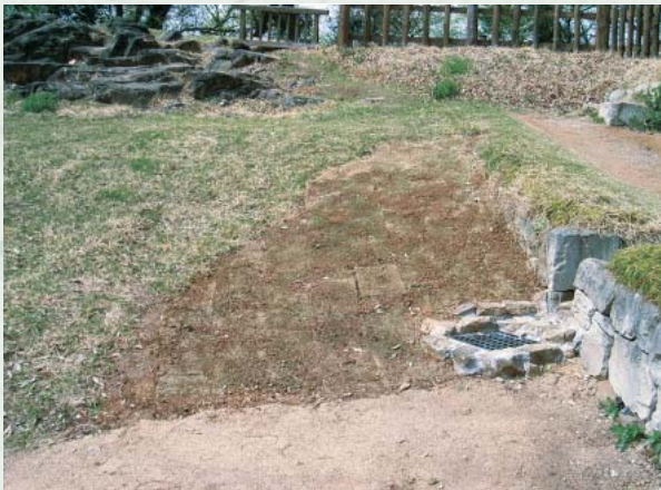
馬場西腰曲輪の排水工事
