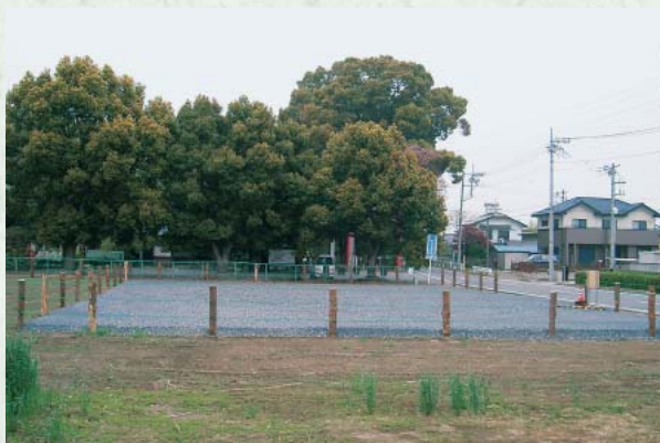
生品神社の仮設駐車場整備
