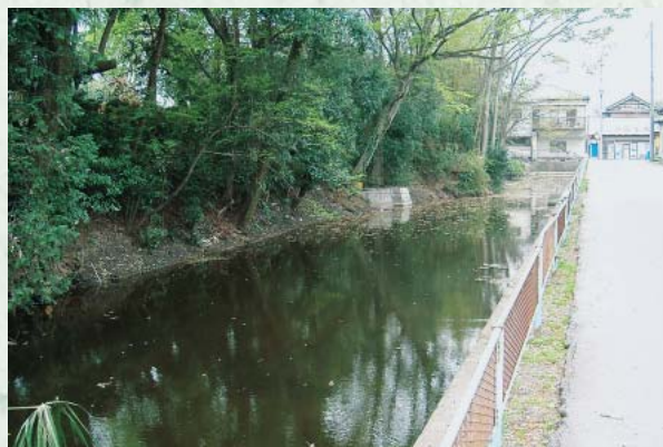
反町館跡の堀浚渫
