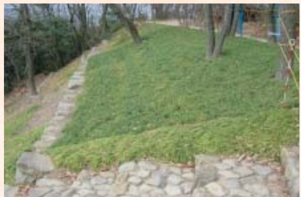
西矢倉台通路脇・法面の植栽工事
