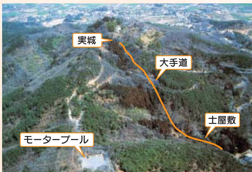
土屋敷調査位置(西から)
