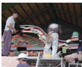
組立て作業（新町の屋台）
