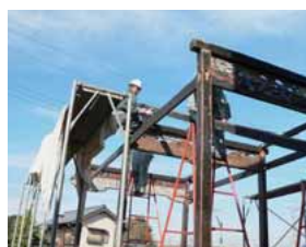
解体作業（上町の屋台）
