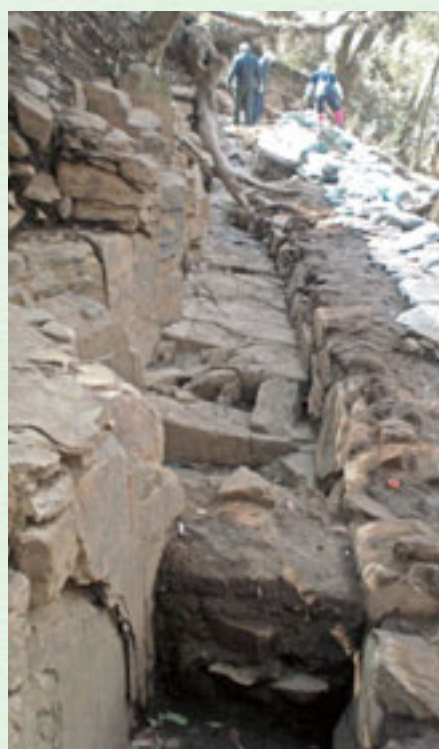
25mにわたり確認された水路
