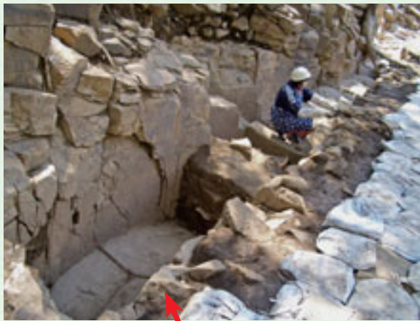
水路全景（北から）
