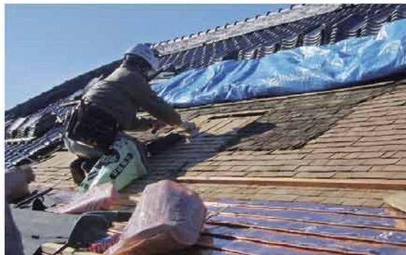
屋根改修工事の様子
