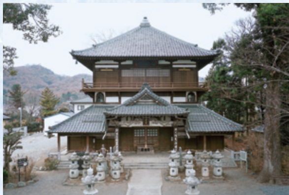
栄螺堂正面（東から）
