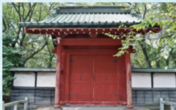
修復前の長楽寺の勅使門（東から）
