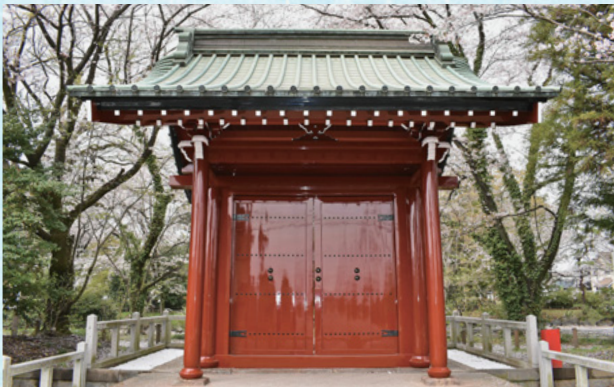
修理後の長楽寺の勅使門（東から）
