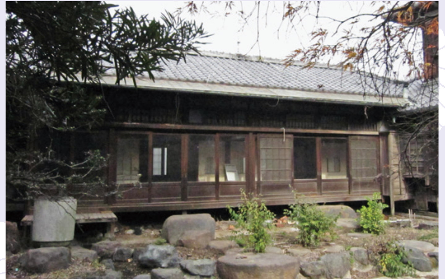
食堂部（改修前）
