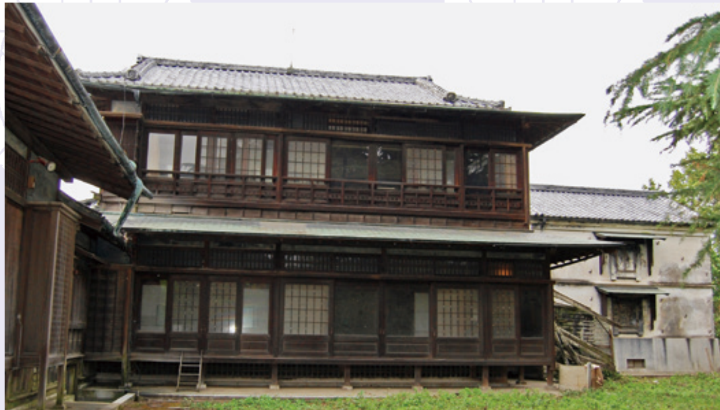
居間部（改修前）
