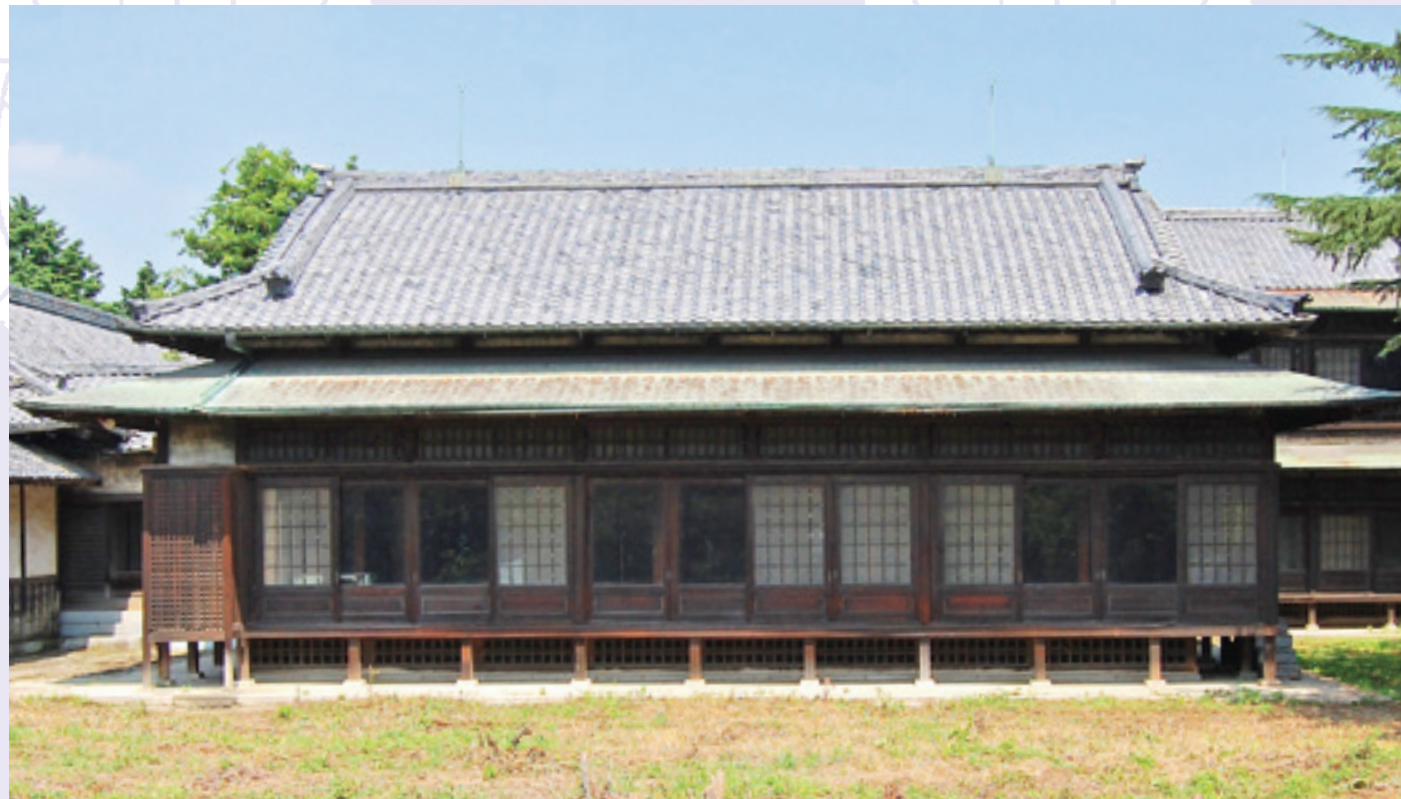
客室部全景（改修前）
