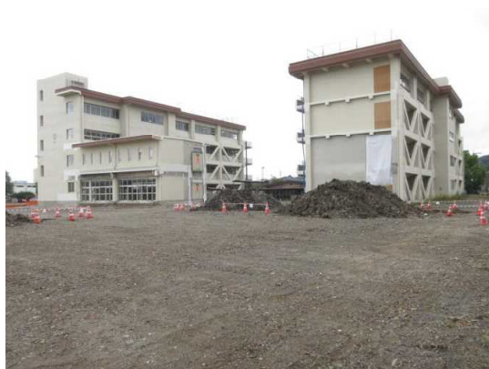
【新校舎建設予定地】
