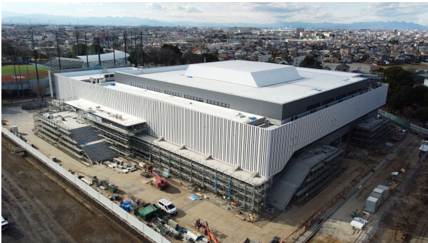
5 総合体育館（建設中）
