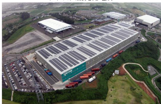
おおた緑町太陽光発電所
