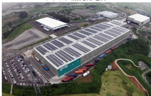
おおた緑町太陽光発電所
