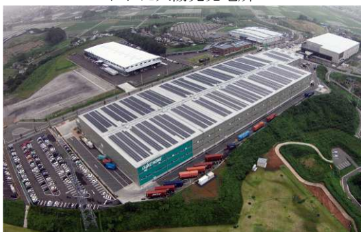
おおた緑町太陽光発電所
