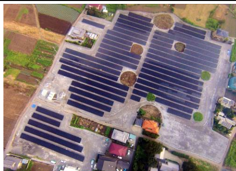
おおた鶴生田町太陽光発電所
