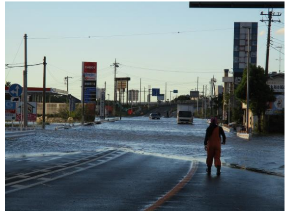
古戸町 国道407号線 刀水橋北 冠水状況
