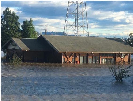
米沢町（ふれあい農園）浸水状況
