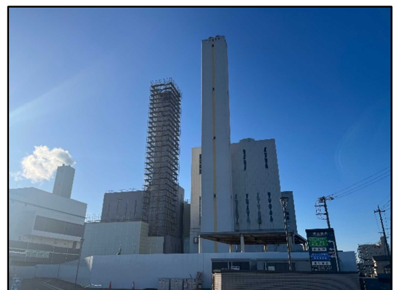
④ 現場全景
