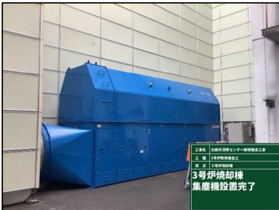
① 集塵機を設置
