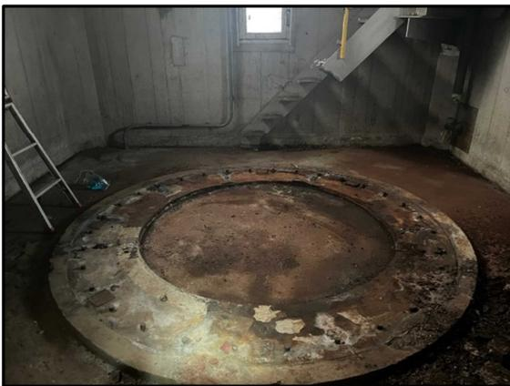
① 3号炉焼却棟 煙突内筒撤去
