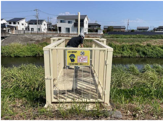
水門・樋門確認訓練 ①
