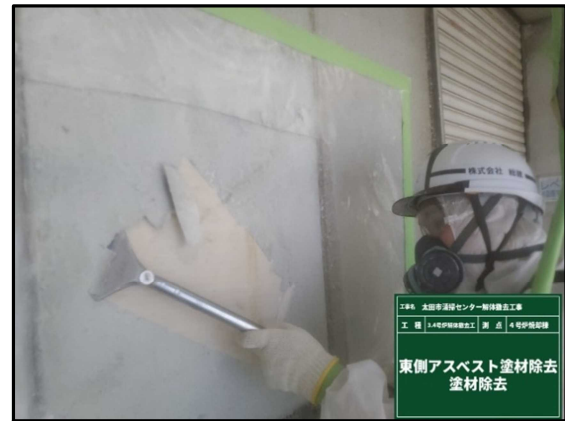
④ 4号炉焼却棟 外壁アスベスト除去
