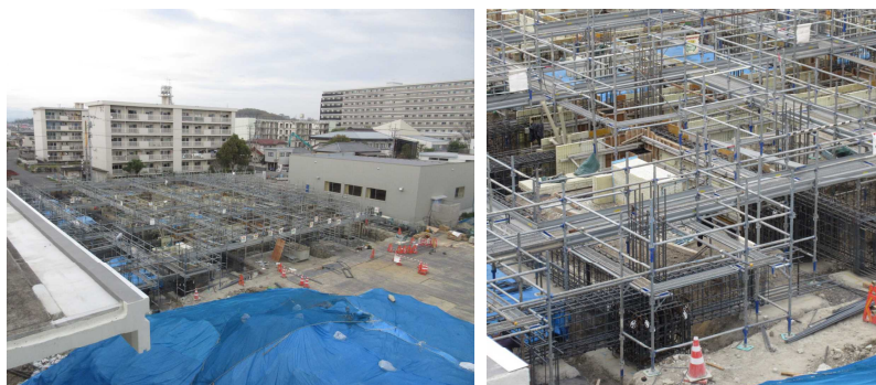
【基礎部分を工事しています】
