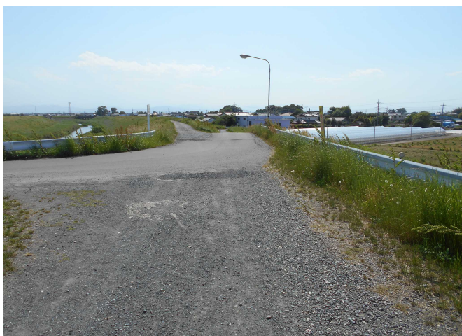
除草前① (上堀口橋北)
