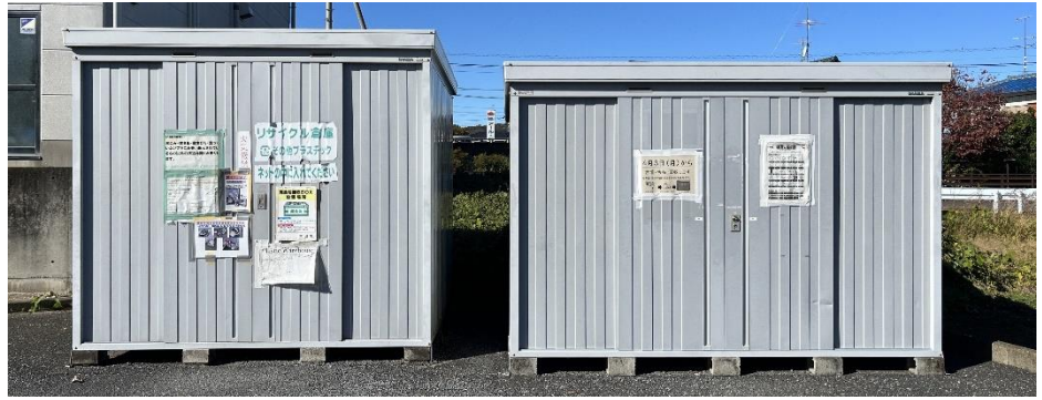
行政センター建物北側
