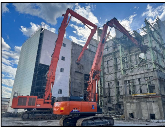
① 3号炉焼却棟 建屋解体
