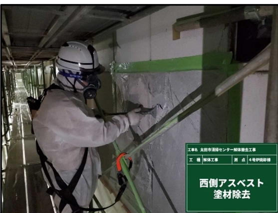
③ 4号炉焼却棟 外壁アスベスト除去
