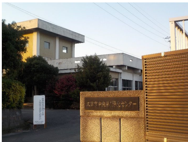
太田市中央第一浄化センター
