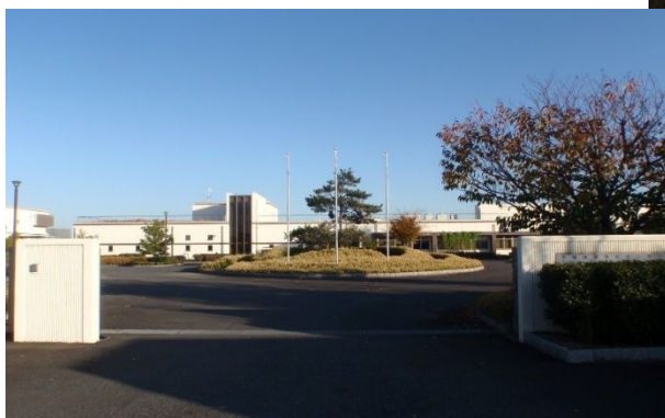
平塚水質浄化センター(佐波処理区)
