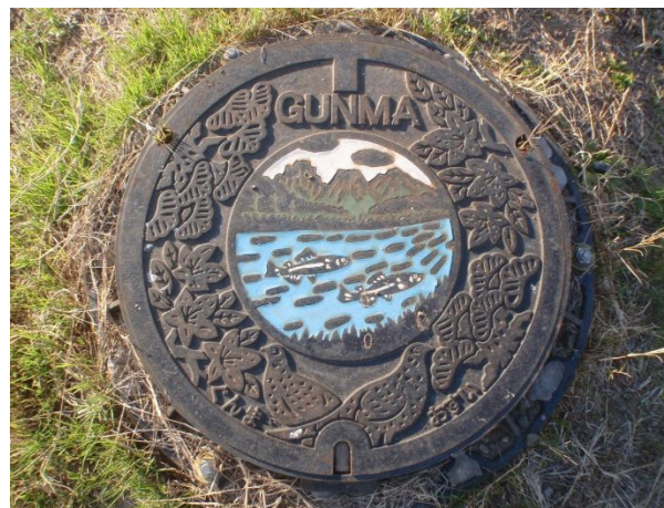
群馬県流域下水道 マンホール
