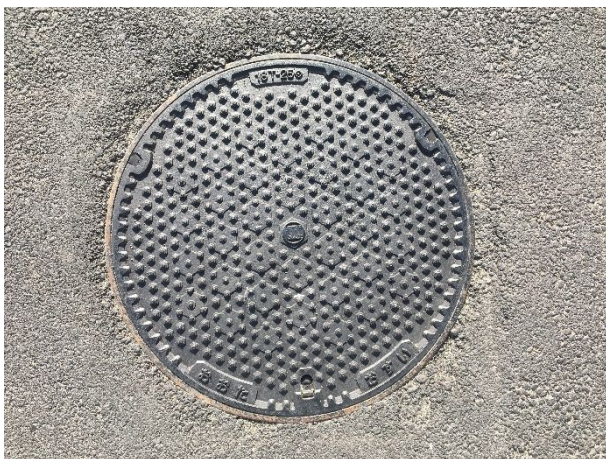
太田市中央処理区 マンホール
