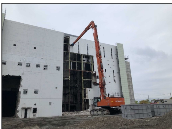
③ 4号炉焼却棟 建屋解体
