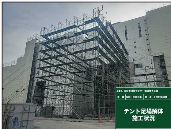
① 4号炉焼却棟仮設テント解体
