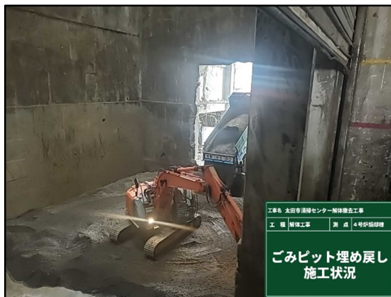
② 4号炉焼却棟 ごみピット埋戻し
