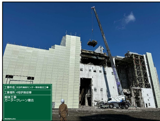
④ 4号炉焼却棟 建屋解体
