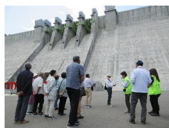
生涯学習推進協議会 館外研修 ハツ場ダムを見学しました
