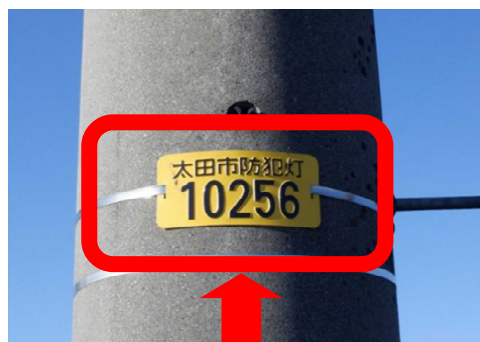
防犯灯管理プレート
