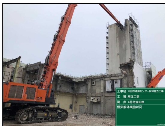
② 4号炉焼却棟 煙突下部解体
