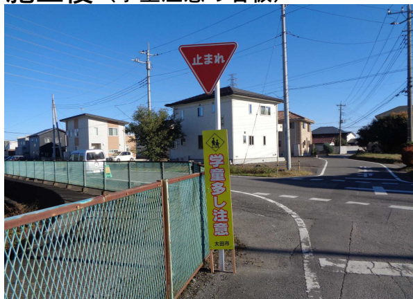
施工後（学童注意の看板）
