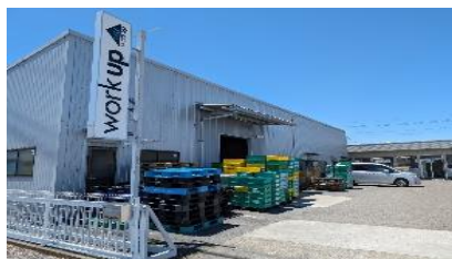
work up 外観
