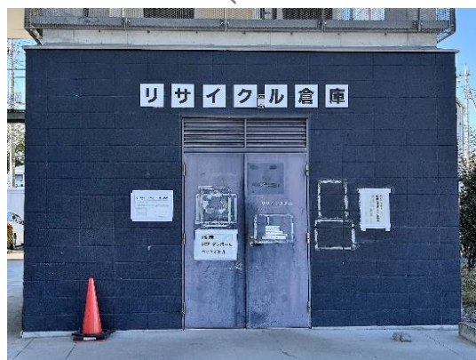
行政センター建物北西側
