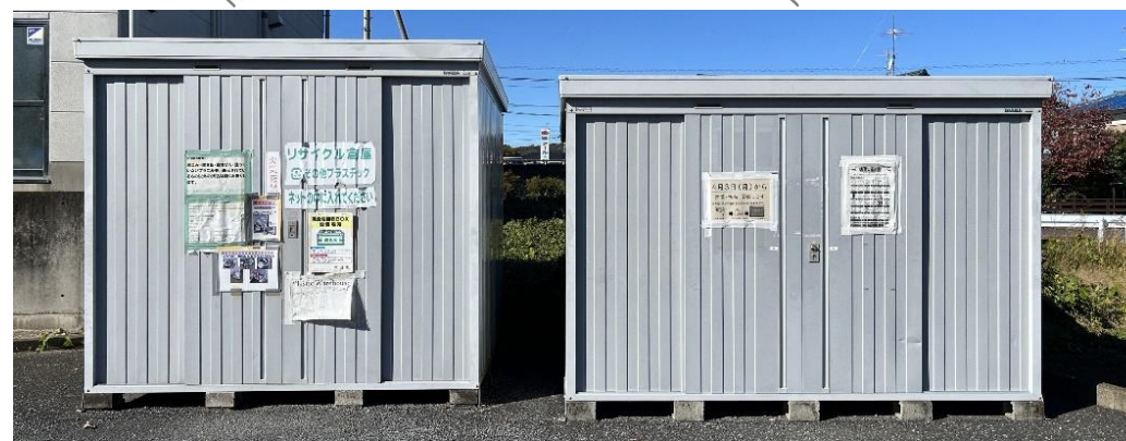
行政センター建物北側
