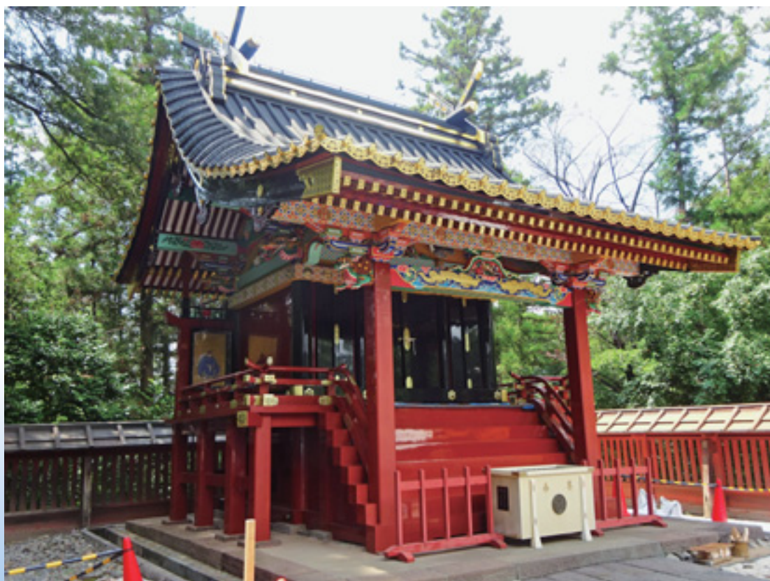
▼本殿 保存修理工事後
