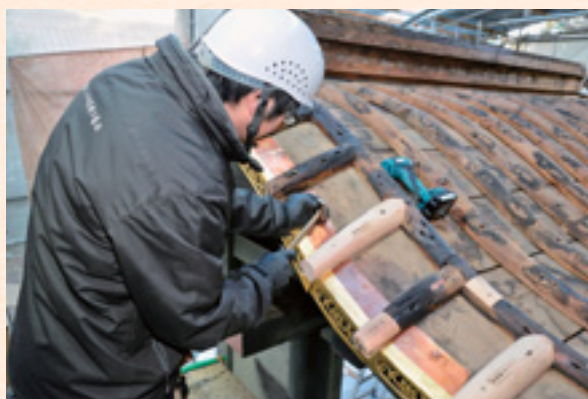
東照宮唐門の修理状況
