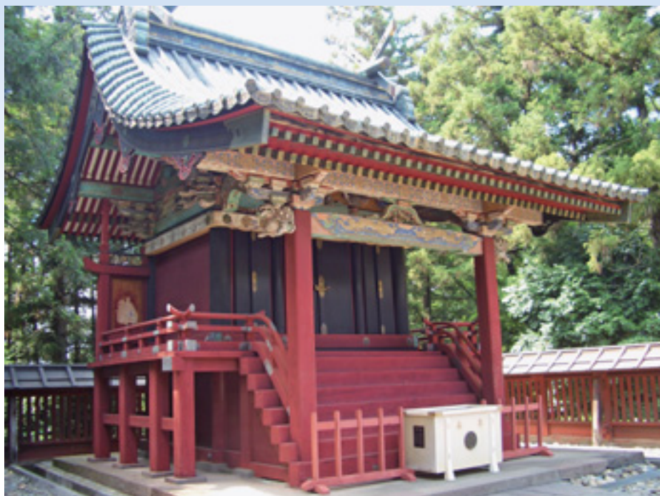
◀本殿 保存修理工事前
