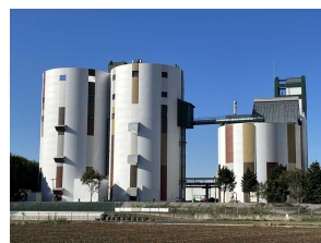
【奨励賞】サッポロビール群馬工場製麦棟
