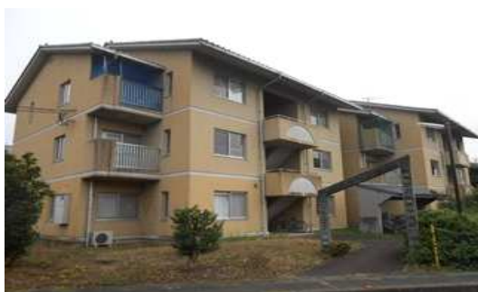
着工前【外壁塗装】
