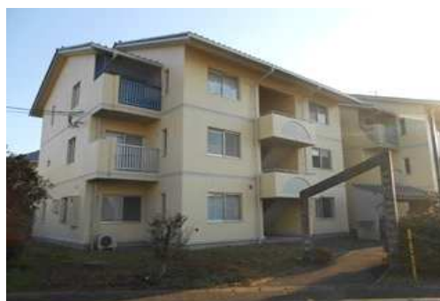
竣工【外壁塗装】
