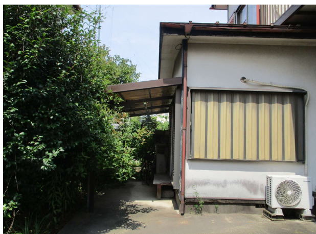
④敷地内(東方から撮影)
