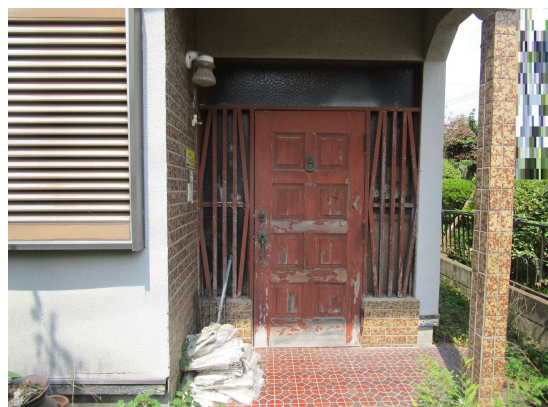
③建物玄関部
