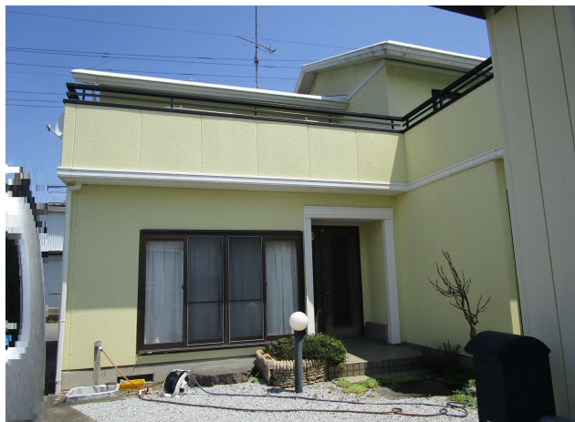
公売財産2 主である建物 正面玄関
