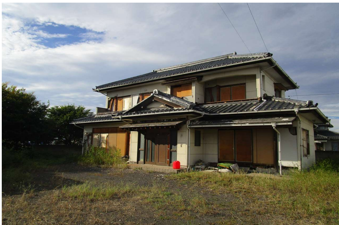
①建物全景
