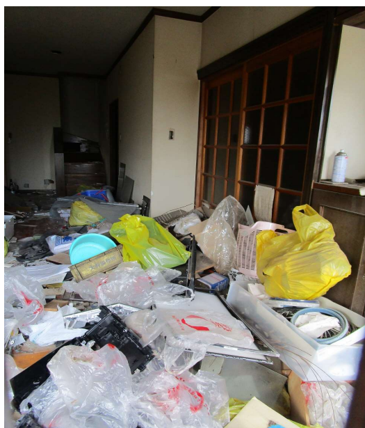
②建物内部状況
