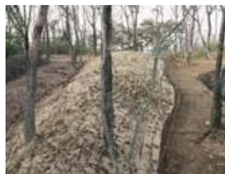
西城筋違い南土塁整備状況
