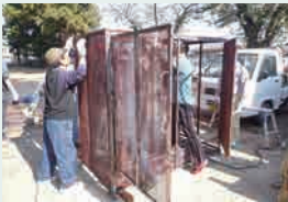
寺井町生ごみ置場整備事業
