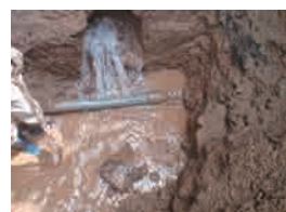
老朽化した管路の漏水
