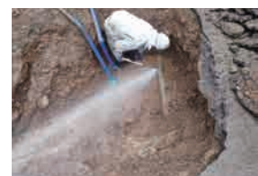
老朽化した管路の漏水
