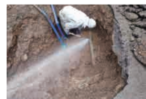
老朽化した管路の漏水
