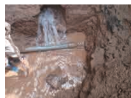
老朽化した管路の漏水
